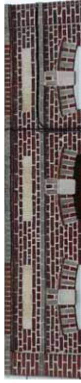
Frises de ciment et linteaux mixtes en briques rouges et briques de ciment
