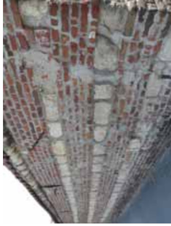
Appareil mixte, dit « rouge-barre » (alternance d'assises de briques rouges et d'assises de pierre) sur un mur d'enceinte
