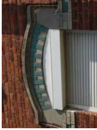
Linteaux en briques de ciment et briques émaillées
