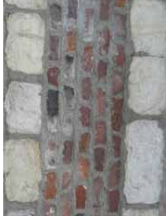
Appareil mixte, dit « rouge-barre » (alternance d'assises de briques rouges et d'assises de pierre) sur un mur d'enceinte
