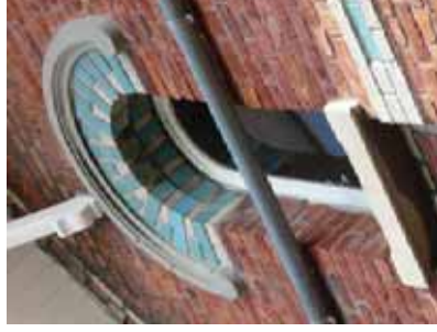
Linteaux en briques de ciment et briques émaillées
