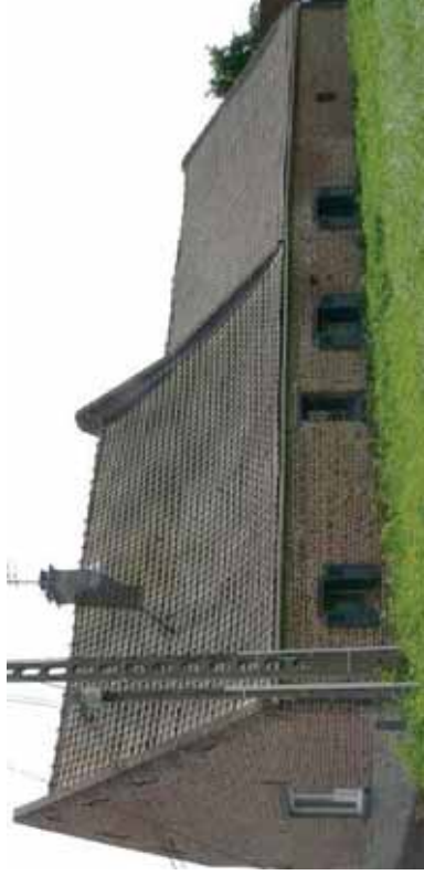
Toitures à longs pans avec pignons découverts, appelés wembergues
