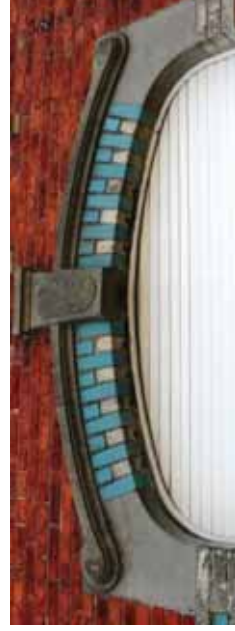
Rosace, linteau mouluré et oculus en ciment
