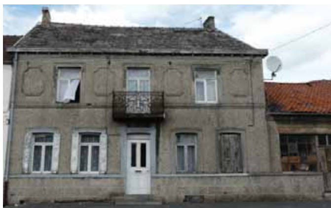
Maison de bourg de la rue Pasteur, flanquée de son ancienne boutique. Il s'agit d'une ancienne boucherie des années 1920 qui tenait aussi le rôle de bistrot.
