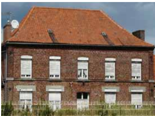
Toiture à croupe. Rue Berthelot.
