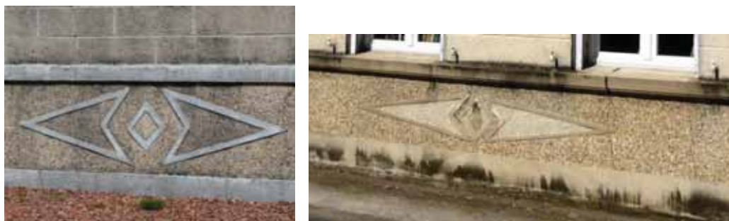
Soubassements en enduit gravillonné. Des motifs identiques se retrouvent d'une maison à l'autre
