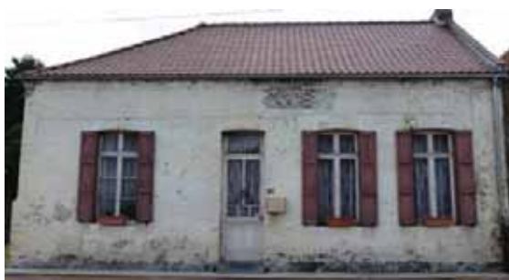
Maison élémentaire à 4 travées et toiture à longs pans et croupe. Menuiseries d'origine. Rue Jean Jaurès.
