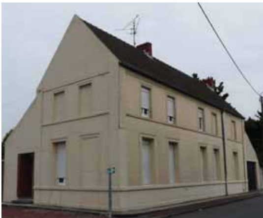
Maison de bourg entièrement enduite au ciment avec un tracé imitant les joints de la pierre de taille
