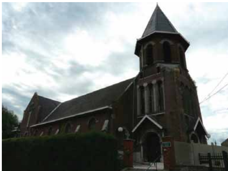
Eglise Saint Maurice, rue de l'église, à Bruille.
