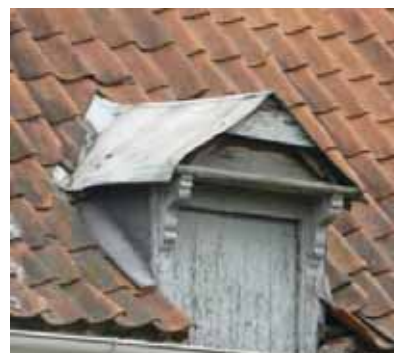
Lucarne pendante ou gerbière et couverture de tuiles flamandes traditionnelles, sur logis agricole
