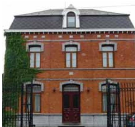
Toiture à croupe et à pans brisés. Rue Jules Guesde.
