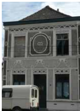
Toiture en pavillon. Rue Pasteur.
