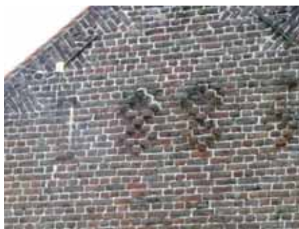
Pignon sur rue, daté.
