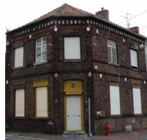
Rue Henri Durre. Cette maison située dans le centre du village de Notre-Dame a servi de commerce de volailles.
