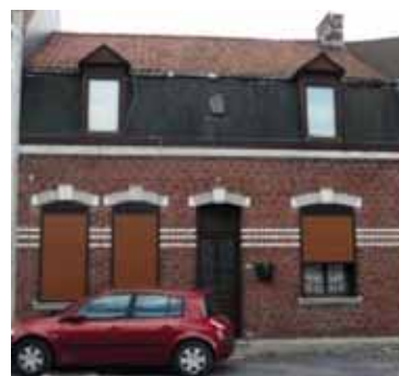
Maison élémentaire à comble en surcroît et lucarnes. Toiture à pans brisés. Rue Pasteur.
