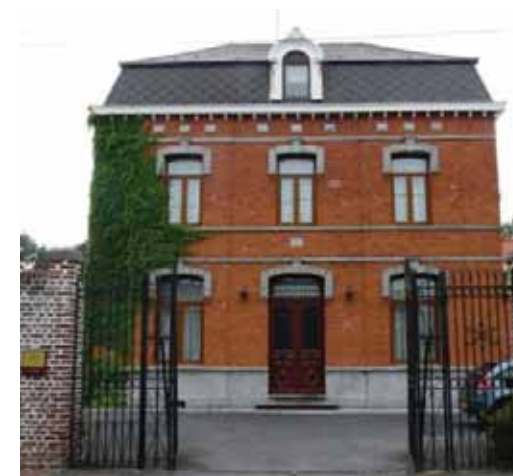
Rue Jules Guesde. Toiture en croupe et à pans brisés. Elle comporte une lucarne moulurée. Les combles en surcroît sont habitables.
