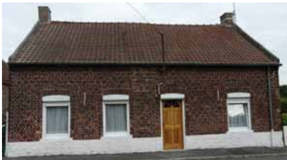
Toiture à longs pans avec pignons découverts, appelés wembergues. Ce modèle de couverture est le plus répandu. Rue de l'église.
