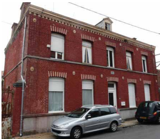
Rue Jean Jaurès. Maison précédée d'un jardinet entouré d'un muret. Toiture en croupe.
