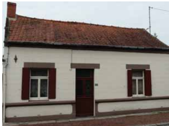
Maison élémentaire enduite au ciment. Le tracé imite la pierre de taille et les claveaux de la plate-bande, au niveau du linteau.
