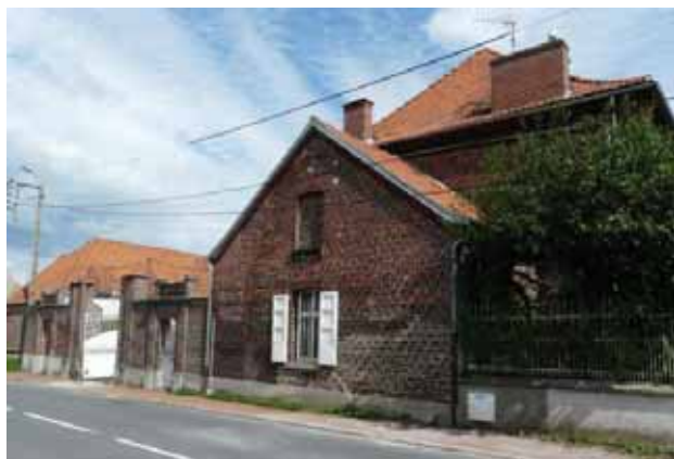
Ferme en U, avec mur d'enceinte. Rue Berthelot.
