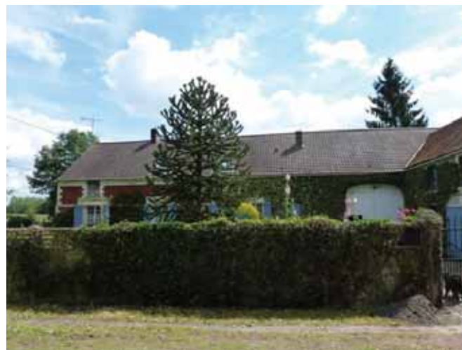
Ferme en L ouverte côté rue. Rue du Bois des Haies
