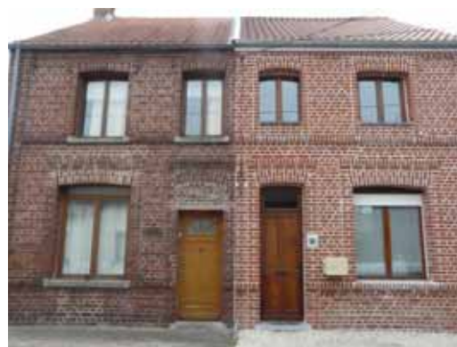
Rue Jules Guesde. Maisons de bourg symétriques à l'origine. Des ouvertures ayant été modifiées, l'effet de symétrie a été atténué. Des rénovations maladroites peuvent dénaturer l'harmonie architecturale.
