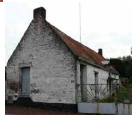
Logis de ferme enduit à la chaux et soubassement goudronné pour protéger le pied du mur de l'humidité
