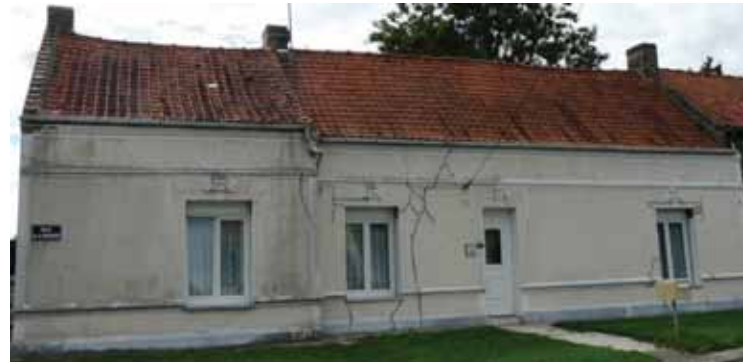
Maison élémentaire enduite au ciment. La façade est lisse et agrémentée d'une frise décorative et de linteaux moulurés
