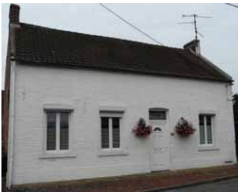
Maison élémentaire en brique avec façade enduite et soubassement de ciment
