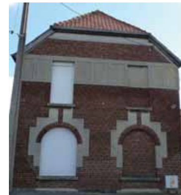
Toiture à demi-croupe. Rue des écoles.
