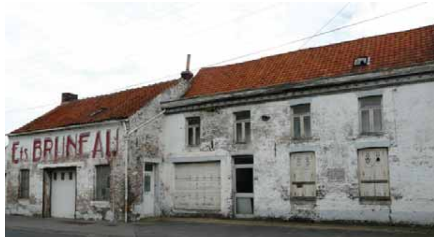
Rue Pasteur. Les établissements Bruneau étaient une ancienne quincaillerie.
