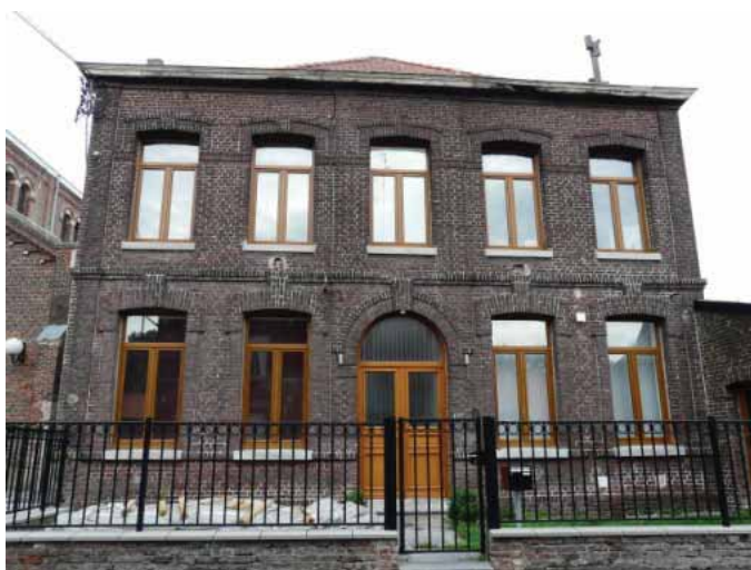
Rue Jules Guesde. Maison précédée d'un jardinet clos par une grille. Toiture en pavillon.
