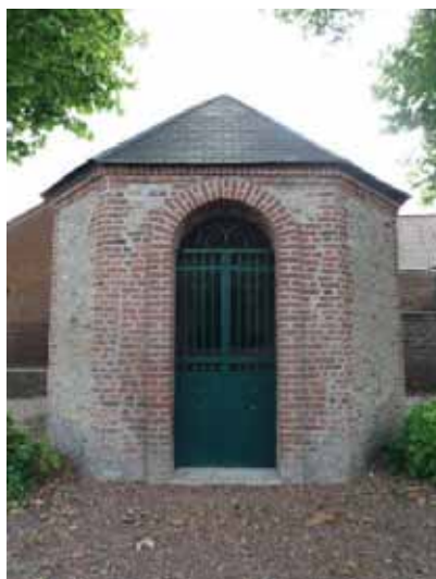
La chapelle Saint Roch. Rue Bertelot.
