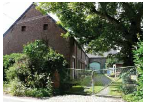
Ferme en L ouverte côté rue. Rue de la Brasserie
