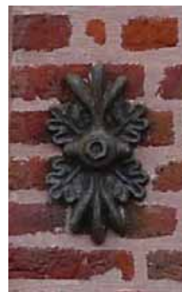
Thème végétal pour ce fer d'ancrage de la façade de l'ancienne école de filles (actuelle médiathèque).
