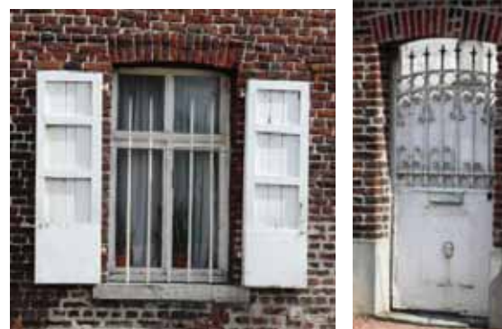
Fenêtre à barreaux en fer forgé Porte de cour en ferronnerie.
