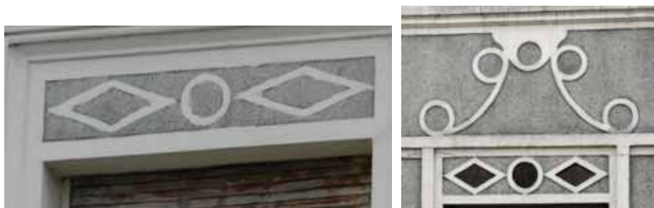
Linteaux de fenêtre en enduit gravillonné, à formes géométriques
