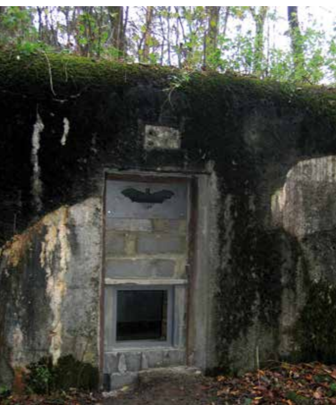
Aménagement d'un blockhaus
