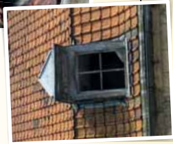
Châssis assis (Lucarne droite)
