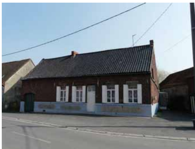
Trois fermes élémentaires repérées au hameau de Rouillon (photo en haut à gauche, ferme au 30 rue de Wiers ; et photo en haut à droite, ferme au 4 rue du Trou Marron). Le corps de logis de la ferme située 58 rue de Wiers (photo du bas) est pourvu d'un soubassement en gravier roulé. Ses huisseries, encore d'origine, sont en bois, avec compartimentage petits bois, et fermées par des volets battants à panneaux.
