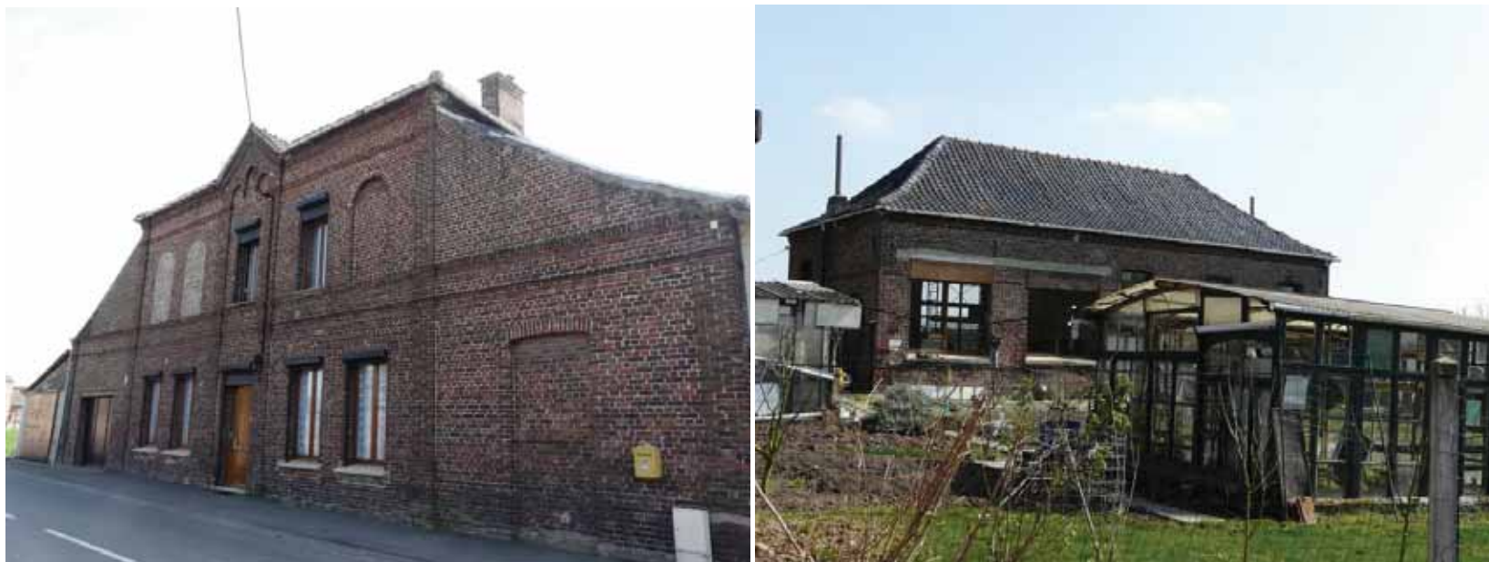
Vues de la façade sur rue et de la façade arrière.
