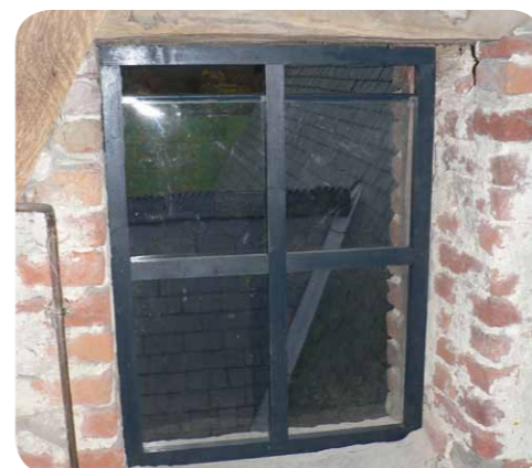
Sur cette église classée aux Monuments historiques, une ancienne fenêtre située dans les combles et donnant sur le pignon arrière a été reconstituée à l'identique. La surface vitrée laisse un accès de 6 cm de haut pour les chauves-souris.
