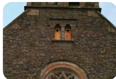
Les fenêtres de ce clocher, dont les vitres étaient totalement hermétiques au passage des chauves-souris, ont été remplacées par des panneaux de bois avec accès aux chiroptères intégrés (croix).
