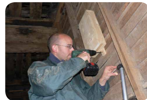
Pose d'un gîte en bois dans un clocher
