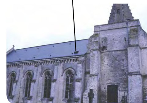
La « chiroptière » permet de créer un accès aux combles en vol. Une réfection de toiture peut être l'occasion de la créer. Cette ouverture doit être large d'au moins 40 cm, haute de 7 cm maximum et si possible exposée à l'est, à l'abri des intempéries.
