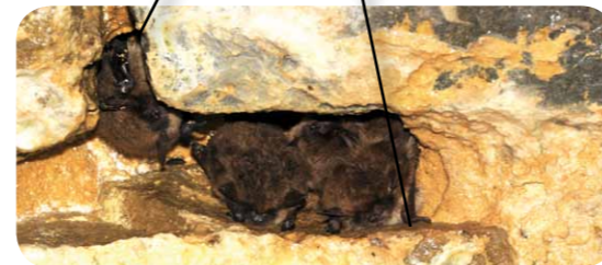
Ce pont de pierre a été « parfaitement » rejointoyé sur toute sa longueur. Seule une petite partie de dix centimètres a été « oubliée », ce qui permet à quatre murins à moustaches de s'installer pour l'hiver.
