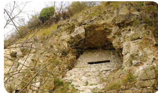
Les anciennes carrières de Cléty
