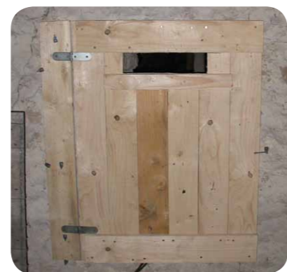
L'installation d'une porte en bois (pourvue d'un passage pour les chiroptères) entre les combles et le clocher présente plusieurs intérêts : cela diminue la luminosité dans les combles et limite les dérangements pour les chauves-souris (porte fermée à clé et panneau d'information installé sur la porte).
