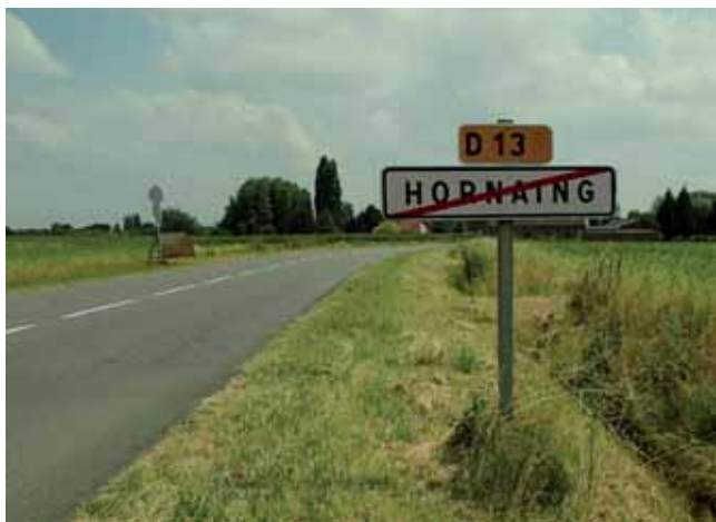
Panneau de type EB20 (panneau de sortie)
