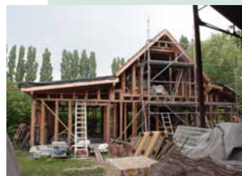
Construction d'un des logements de la Cense Inverse
