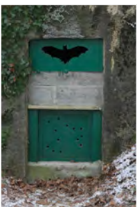
Aménagement d'une entrée de blockhaus réservée aux chauves-souris.
