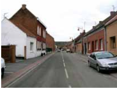
Un traitement d'une voirie principale en traversée de bourg, associant sobriété des matériaux et effacement de réseau (Vred)
