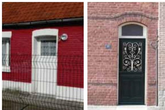
Détails sur des portes d'entrée. Bien que d'époque différente, elles sont toutes deux composées d'une imposte vitrée en partie haute et d'un ouvrant en bois.
