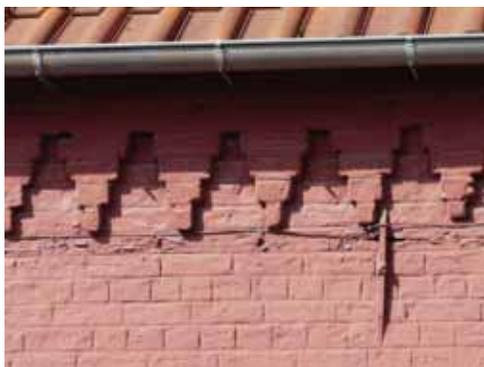
Exemple d'une corniche composée de triangles posés sur la pointe. Les corniches sont les ancêtres de nos gouttières. Saillantes par rapport au nu du mur, elles permettaient aux eaux pluviales de s'écouler à l'aplomb des maçonneries, sans ruisseler dessus et donc les détériorer.
