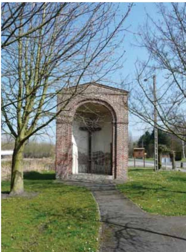
Simple construction de brique au plan semi-circulaire, le calvaire de Vred est pourvu d'une abside en cul-de-four dans laquelle prend place une croix, à l'ouverture en plein cintre couronnée d'un fronton triangulaire. Cette abside est couverte d'une croupe polygonale en tuile mécanique. La façade postérieure est animée de contreforts.
