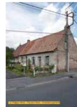
Deux exemples de fermes élémentaires (rue du Pont pour celle de gauche, rue des Frères Sans pour celle de droite) dont les maçonneries sont recouvertes d'un ancien badigeon de chaux, rouge ou blanc.
