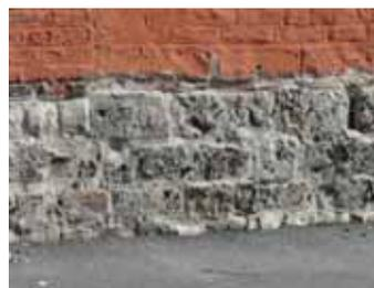
Le grès se retrouve plus rarement sur les édifices Vredois. Il est le plus souvent utilisé en soubassement et notamment sur les murs d'enceinte des fermes. Le grès étant une pierre moins friable que la brique de terre cuite, il protège la base du mur contre les éclaboussures d'eau de pluie.
