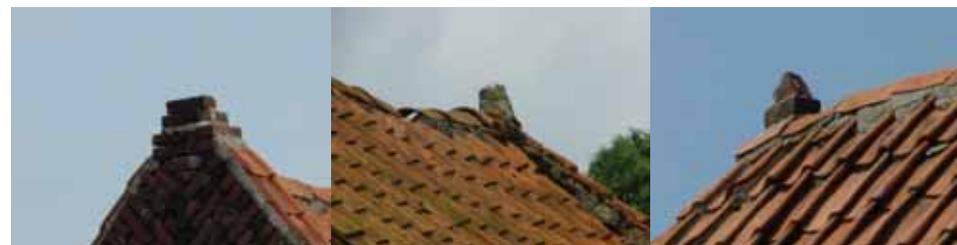
Amortissements au fait du toit sur les pignons des bâtiments : briques posées sur champs à l'aide d'un mortier à base de sable et de chaux (centre bourg et Planche d'Alnes).
